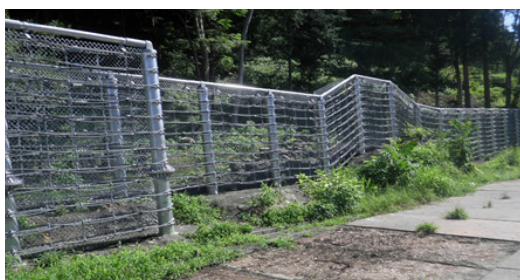
3号崩壊土砂防止柵
